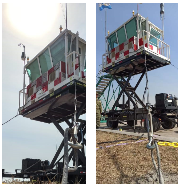
A modo de ejemplo. Placas metálicas de anclaje para arriostamiento de TWR FAA
