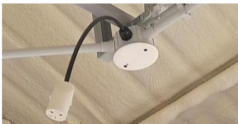
Las luminarias indicadas como emergencia "EQ", contarán con un equipo autónomo conectado al circuito de luz de emergencia. En este caso de la caja octogonal saldrán dos chicotes terminados en fichas de toma con tierra, a través de su respectivo prensacable, el chicote de emergencia contará con una identificación tipo bandera.
