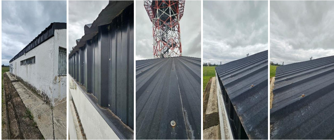
Imágenes ilustrativas de la cubierta de chapa del edificio Radar.
