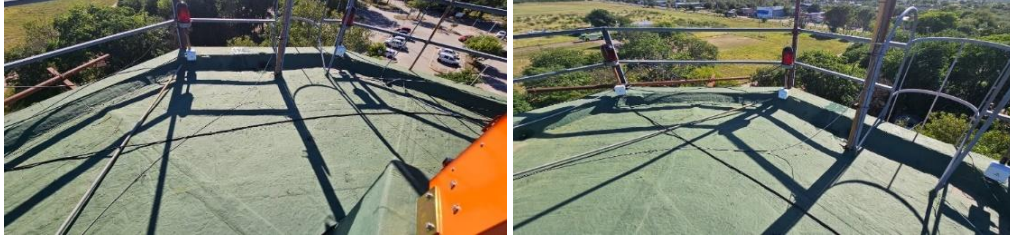
Imágenes representativas de cubierta de cabina de control.
