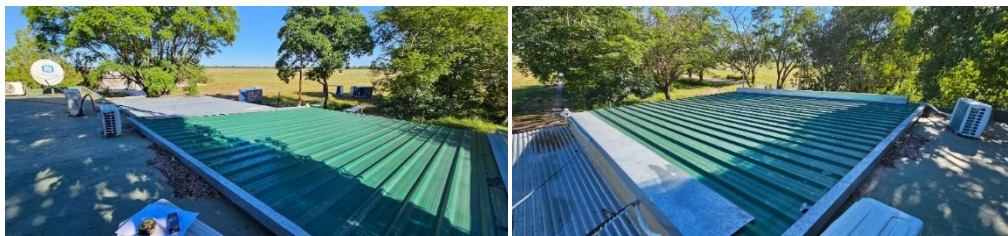
Imágenes representativa de cubierta de chapa trapezoidal verde.
