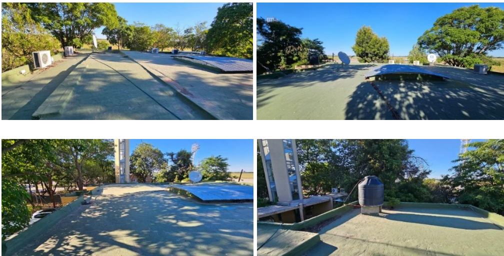
Imágenes representativa de cubierta plana del edificio operativo.
