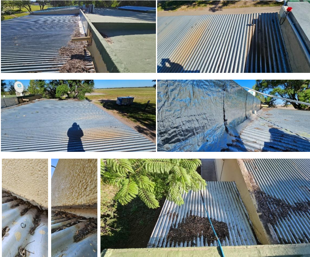
Imágenes representativa de cubiertas de chapas acanaladas.
